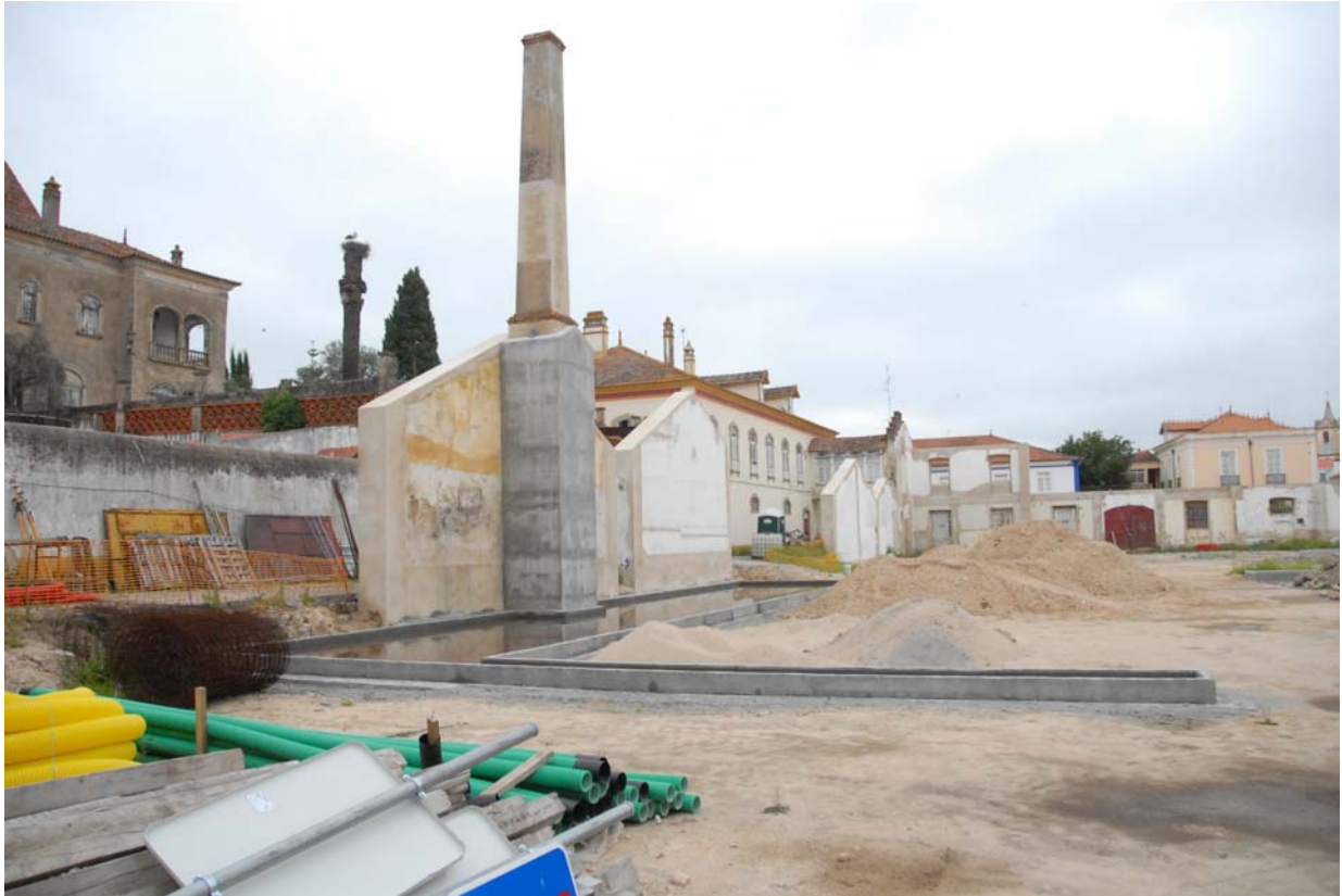
Figura 1 - Vista de uma parte da Obra
