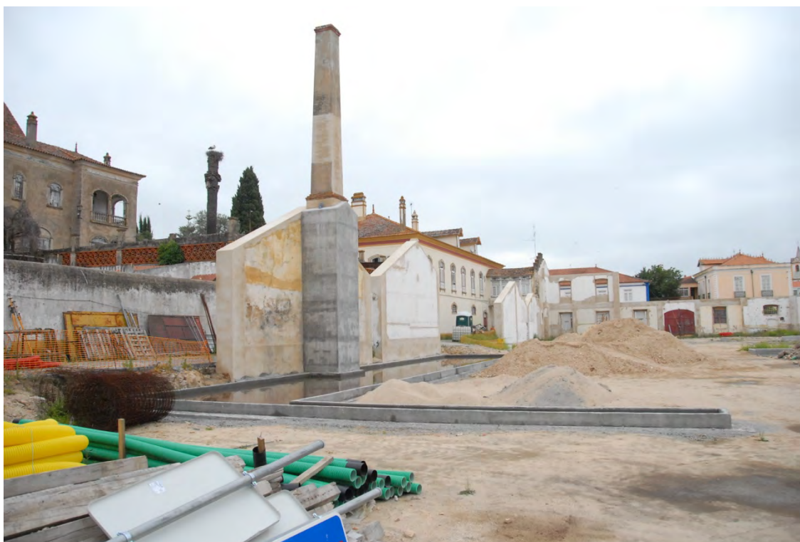
Figura 1 | Vista de uma parte da Obra (09/05/2018)
