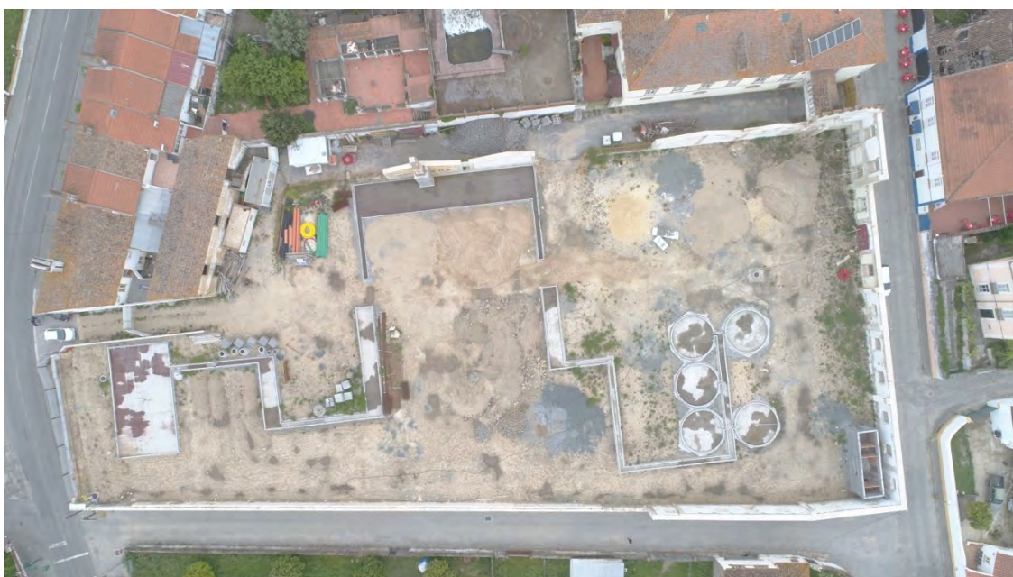
Figura 3 | Vista Aérea da Intervenção (09/05/2018)
