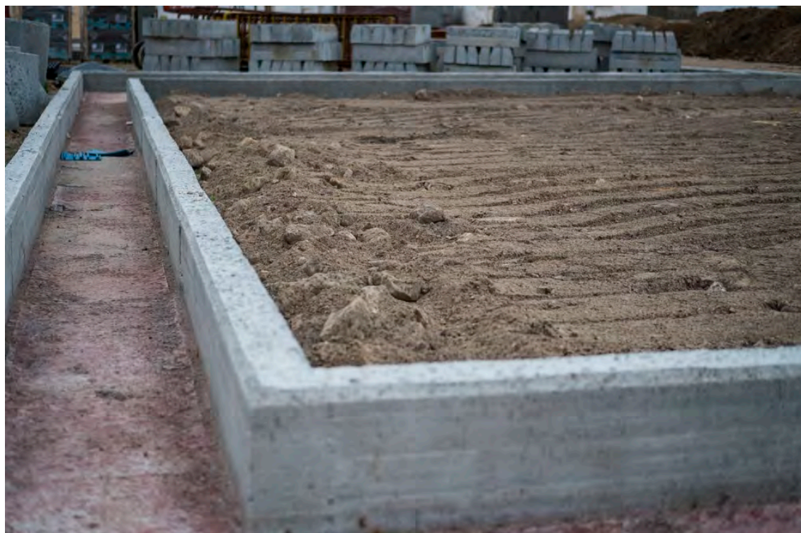
Figura 7 | Pormenor Construtivo Zona de Estar . 07 (07/06/2018)
