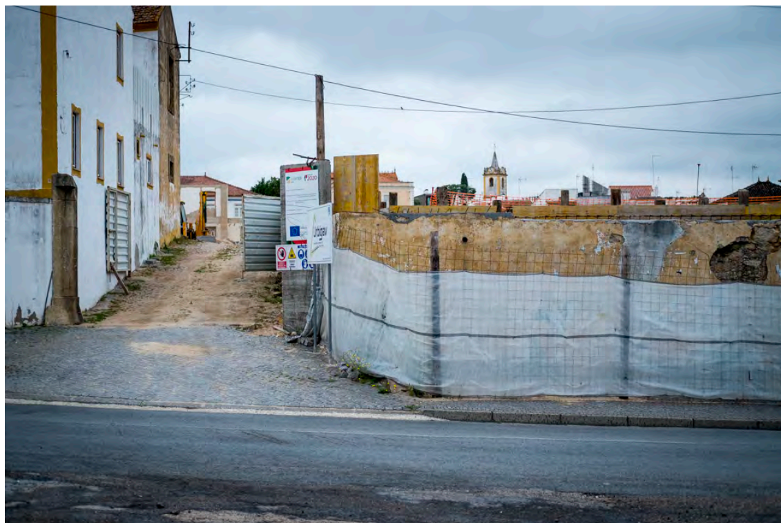
Figura 10 | Vista Entrada/Saída junto aos Bombeiros Voluntários (07/06/2018)
