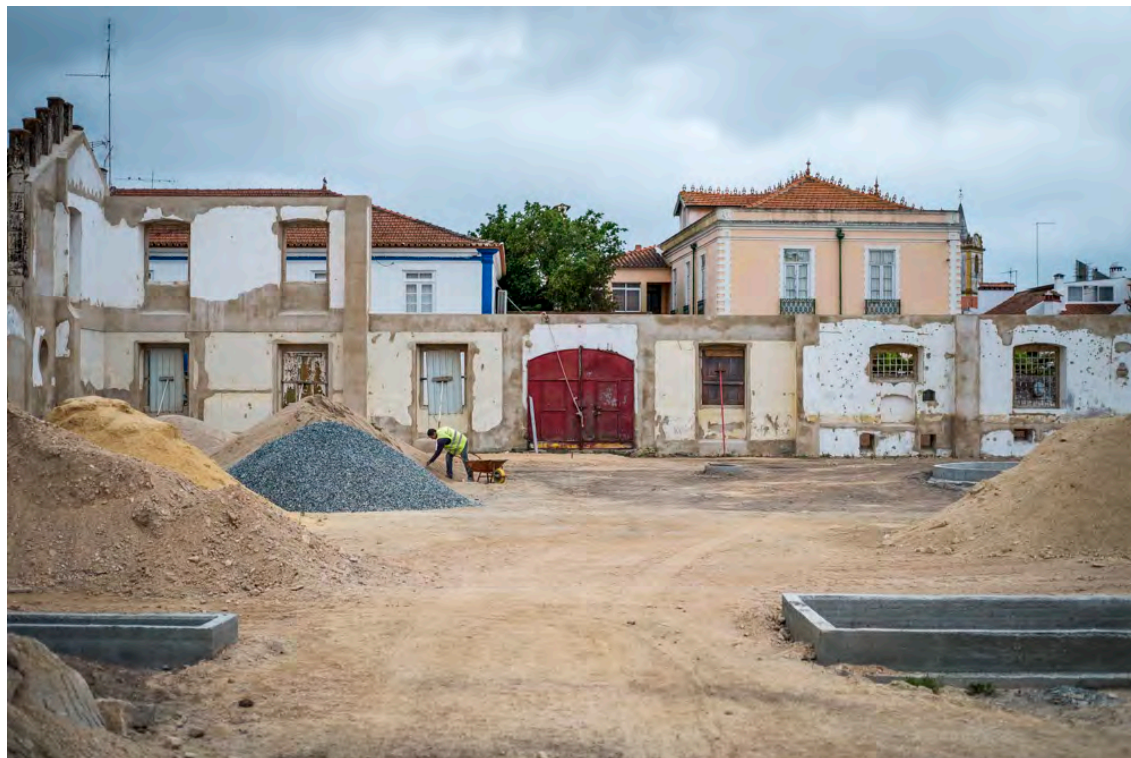
Figura 9 | Vista para Entrada/Saída junto à zona de Estar . 01 (07/06/2018)
