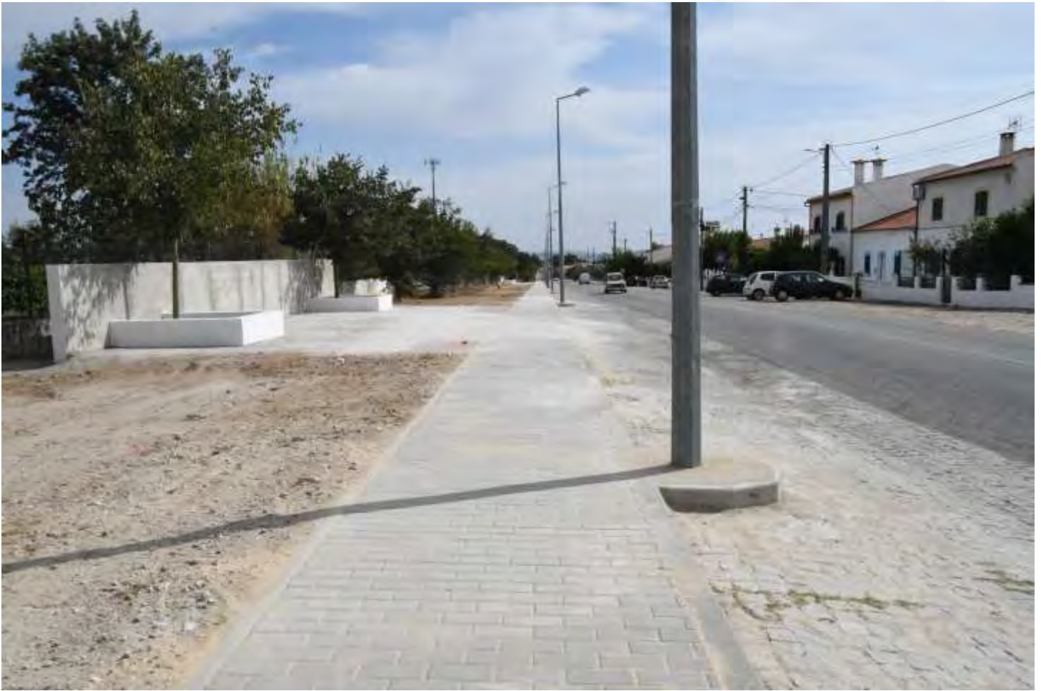
Foto 3: Continuidade dos trabalhos
