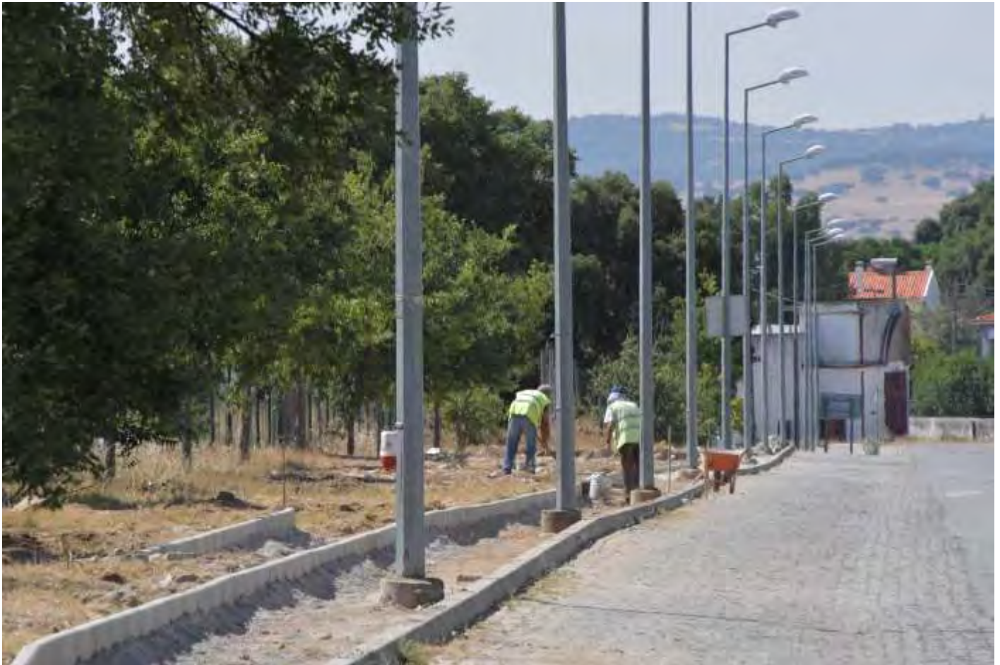
Foto 2: Continuidade dos trabalhos iniciais
