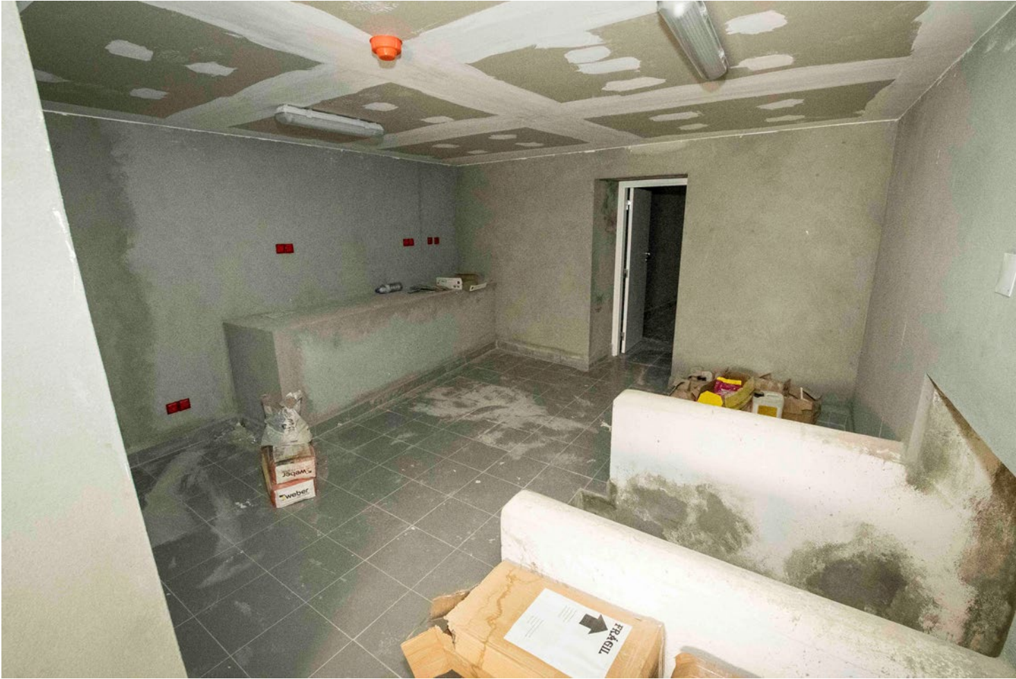
Trabalhos a realizar
