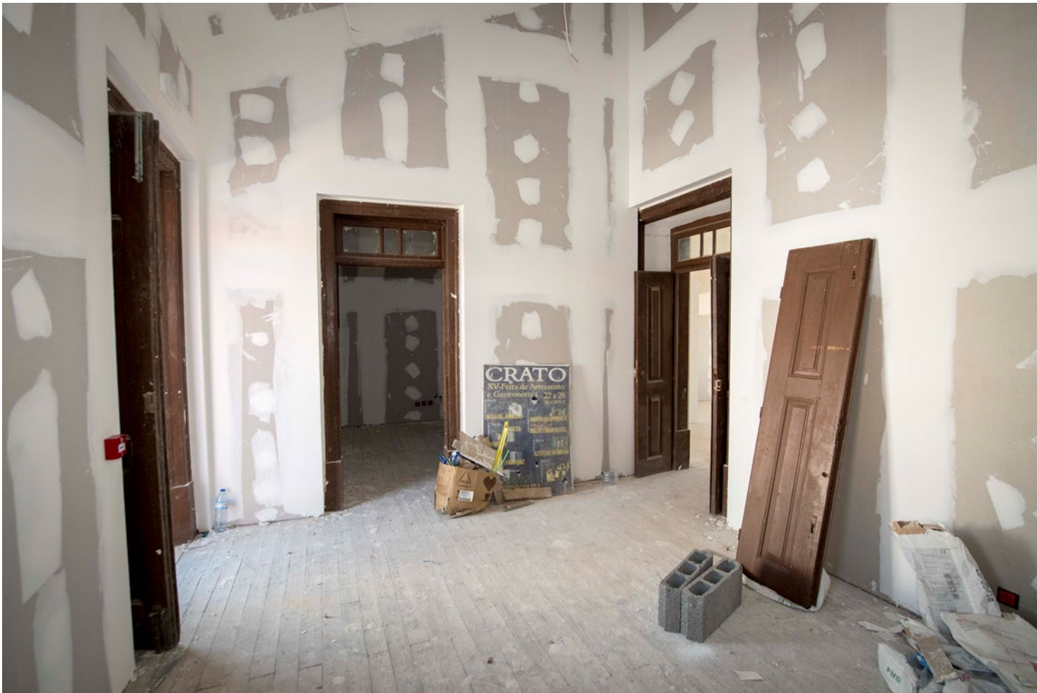
Trabalhos a realizar
