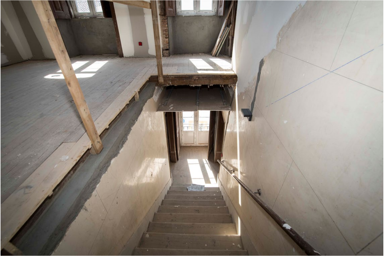
Trabalhos a realizar na escada interior
