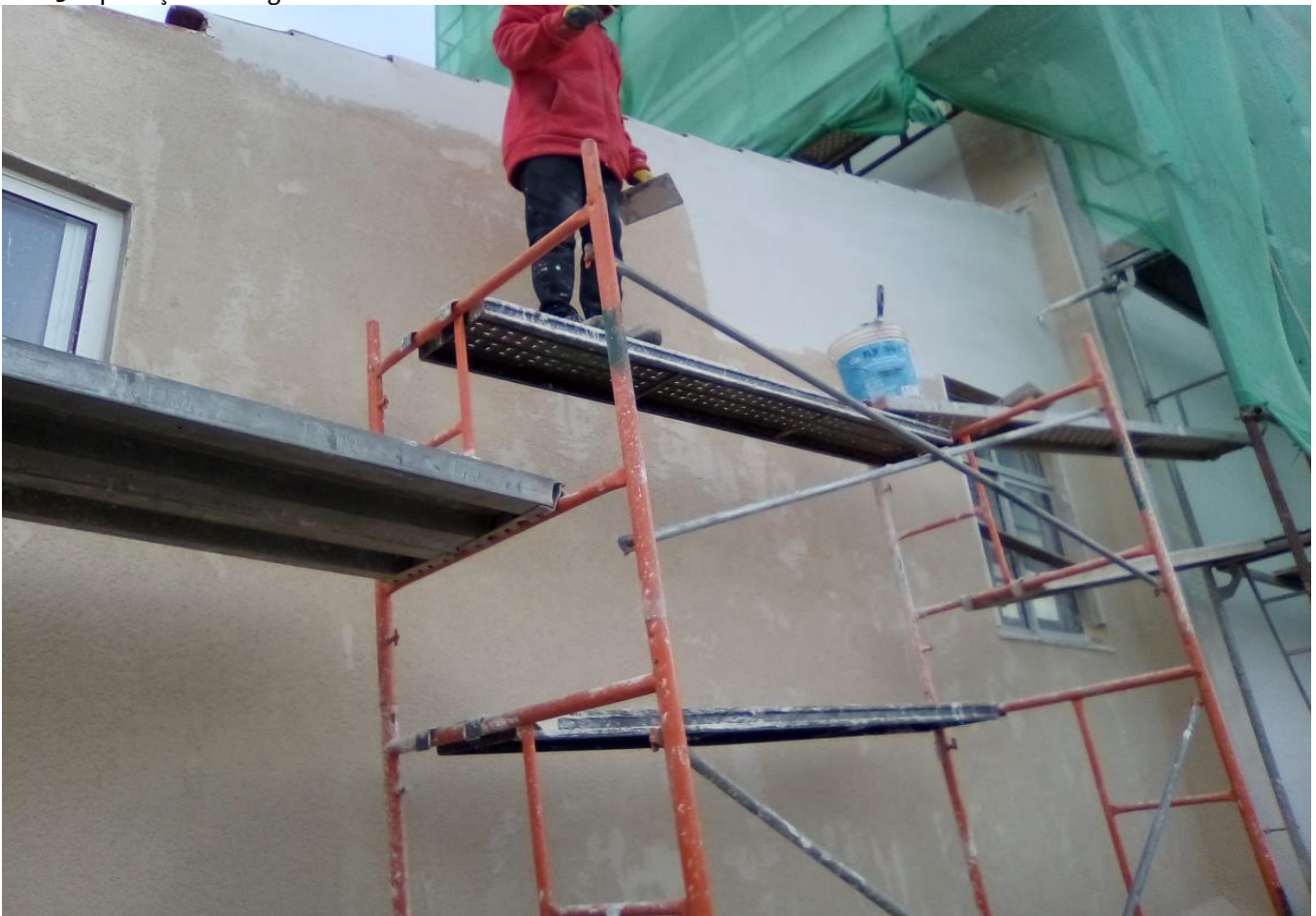
Foto5: Aplicação de Argamassas
