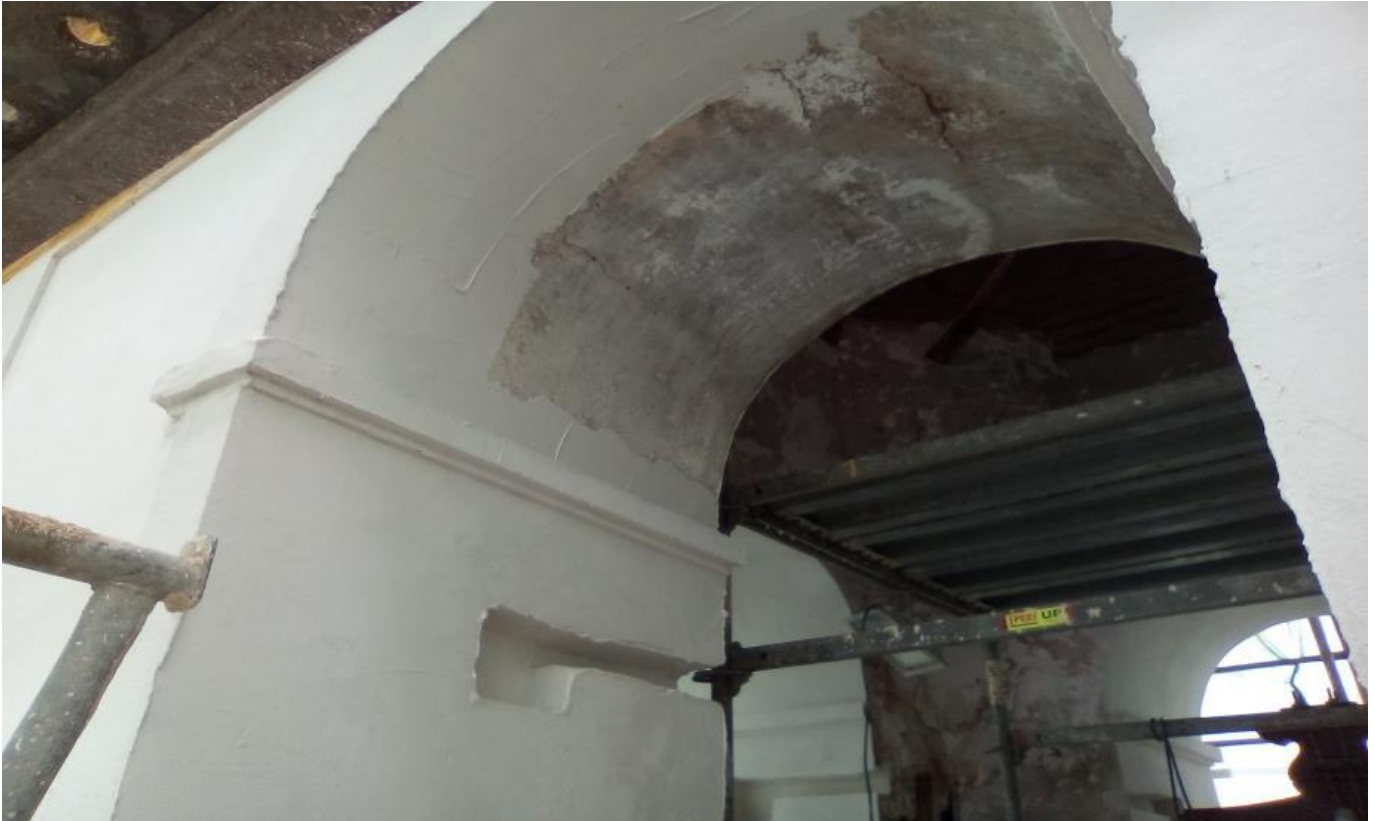
Foto 2: Continuidade dos trabalhos iniciais
